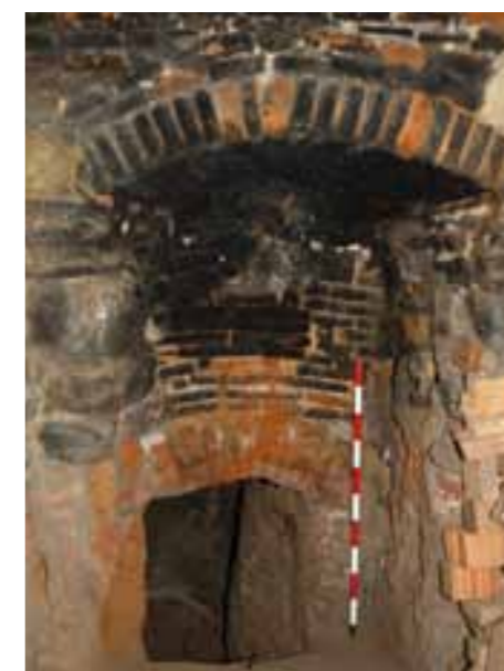
Vista exterior de la boca del forn de baix
